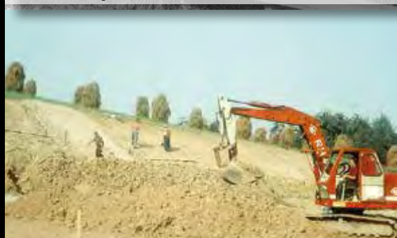
1970 – Platz-Neubau in Katzing
